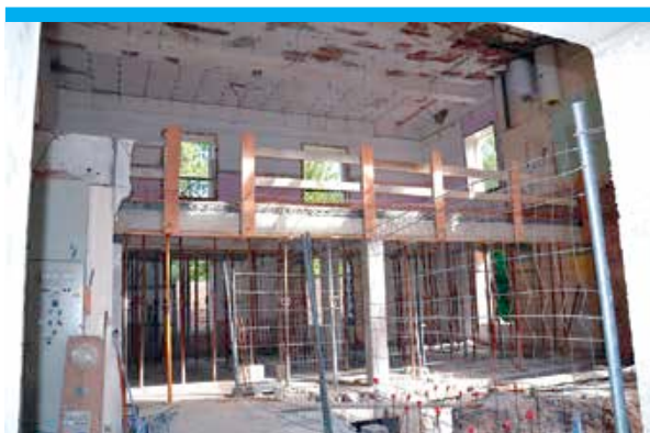
État des travaux en septembre 2018 © Monique Lassigne
