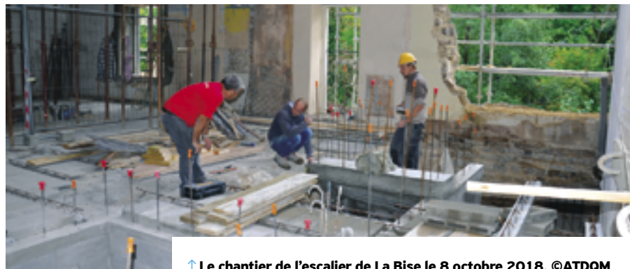
↑ Le chantier de l'escalier de La Bise le 8 octobre 2018. ©ATDQM
